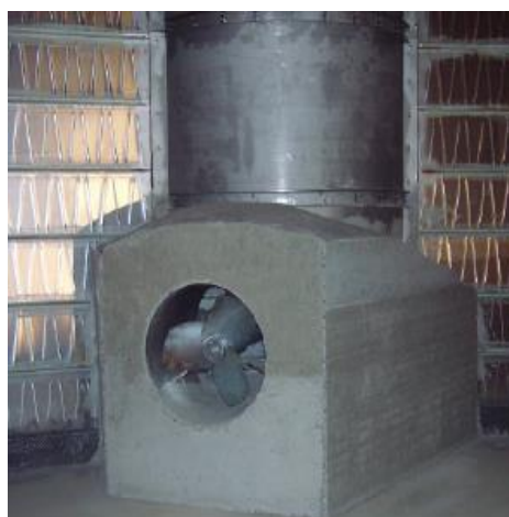
Figure 22 : Agitateur Lipp® avec puit d'aspiration du Digelis Simplex®
