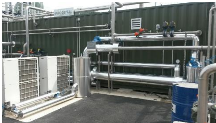
Figure 39 : Sécheur et groupes froid
