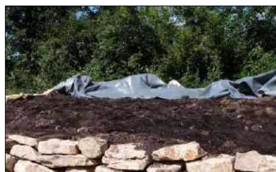
Exemple de site de ponte réalisé par ECO-MED
