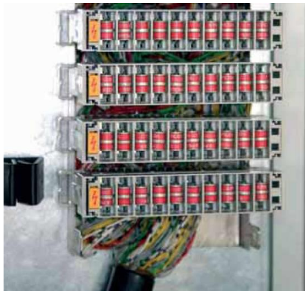
Figure 22 : Exemple de parafoudres sur bornier téléphonique type LSA
